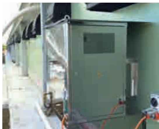
Montáž vně budovy
