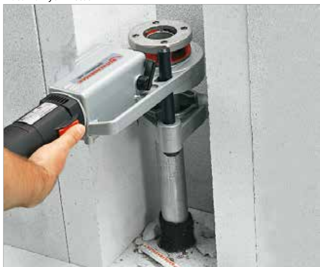
Práce v úzkých místech
