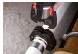
Uchopení lisovacích kroužků pomocí mezičelisti
