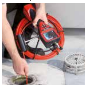
Inspekce potrubí pro svod dešťové vody
