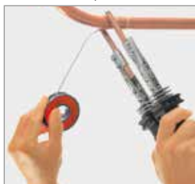
Nahřívání pájeného spoje bez otevřeného plamene
