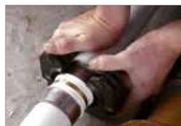
Přiložení lisovacího kroužku
