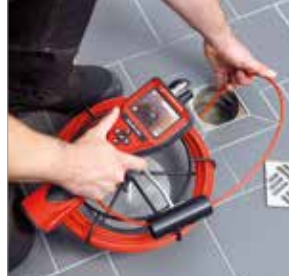
Inspekce podlahových odpadů
